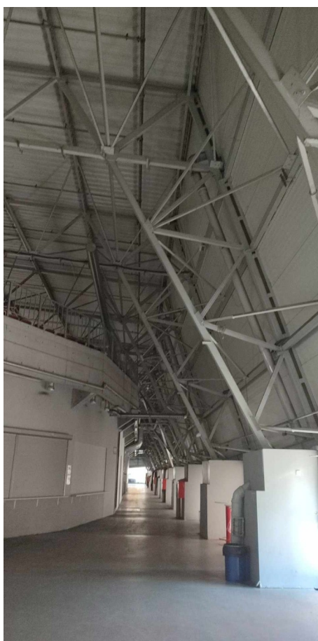
Zdj. 4 Widok konstrukcji węzła kratowej ramy.
