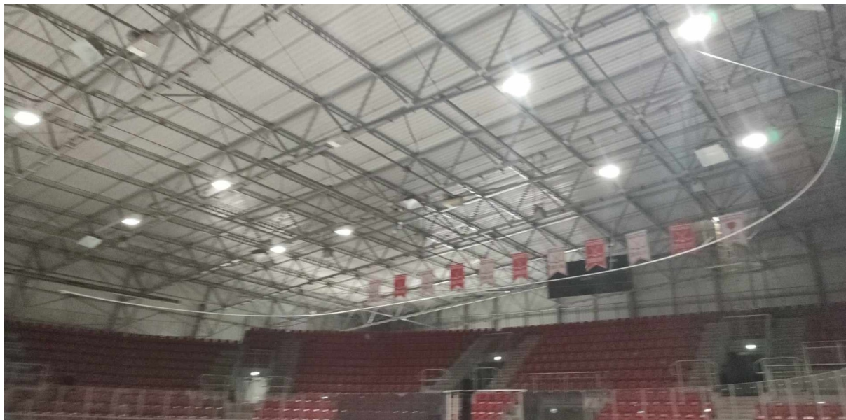
Zdj. 1 Widok konstrukcji więzara stalowego
